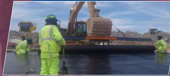
Servicio de instalación de geomembrana
