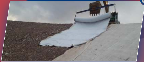
Servicio de Instalación de GCL ( Geotextil)
